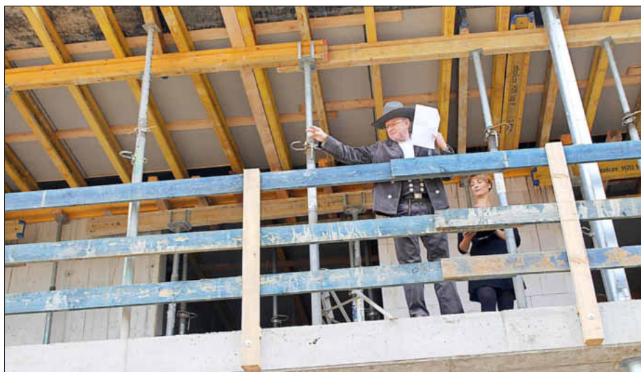
Herr Hofbeck beim Richtspruch, Foto: besc
