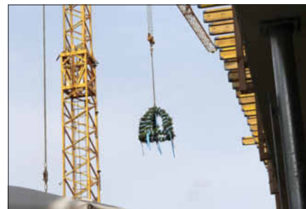
Richtfest der neuen KITA in Memmelsdorf: „Wer in Kinder investiert, investiert in die Zukunft!“, Foto: besc
